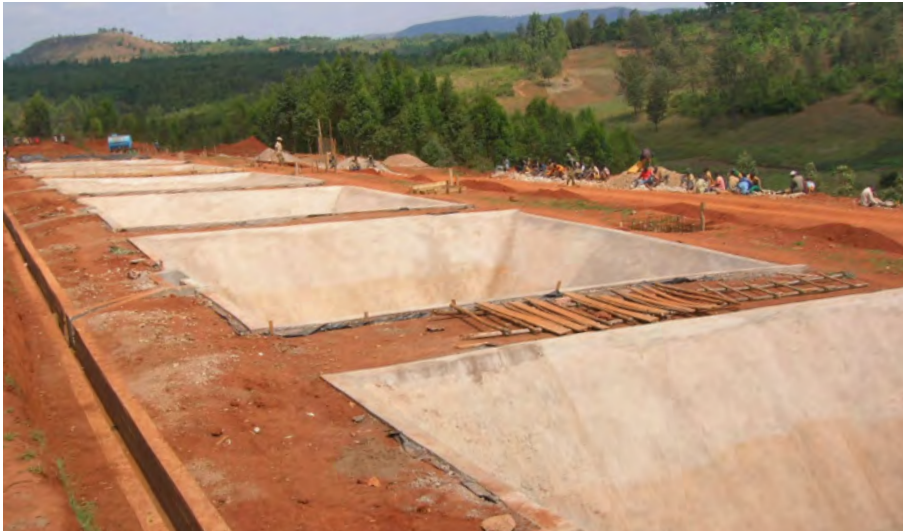
Imagem: Camas de secagem de lamas em construção. Crédito: B. Koelsch
