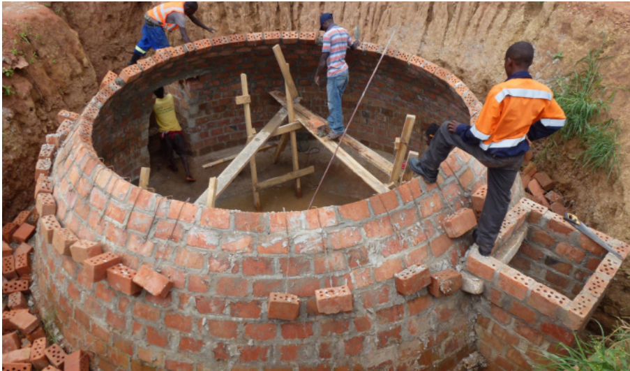
Imagem: Estação de transferência FSM em construção em Chazanga, Lusaca
