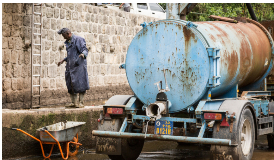
Imagem: Estação de tratamento de águas residuais, Addis Abeba, Etiópia. Crédito fotográfico: Chris Terry
