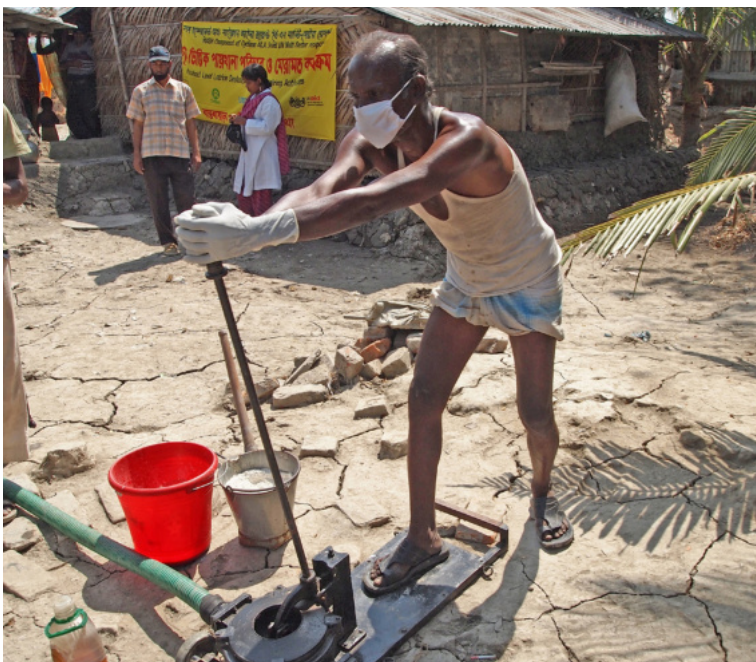
Imagem: Esvaziamento manual da latrina de fossa em Khulna, Bangladesh
